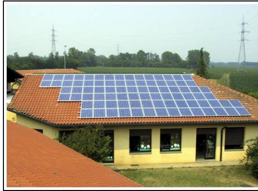
Applicazione su tetto inclinato “retrofit”
